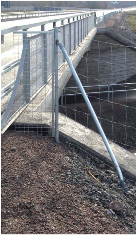
Tätning mellan vilstängsel och broräcke.
