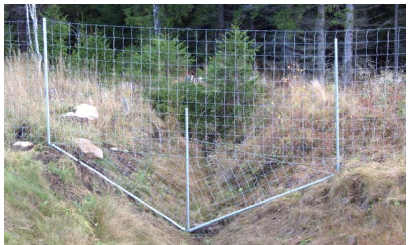
Diketätning med nedklippt nät och förankring.
